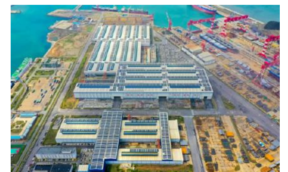
陆岸船舶修造企业在屋顶安装光伏电站，积极使用绿色能源，减少碳排放
